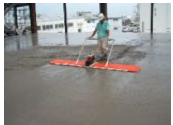
写真11 サーファーによる転圧・均し
