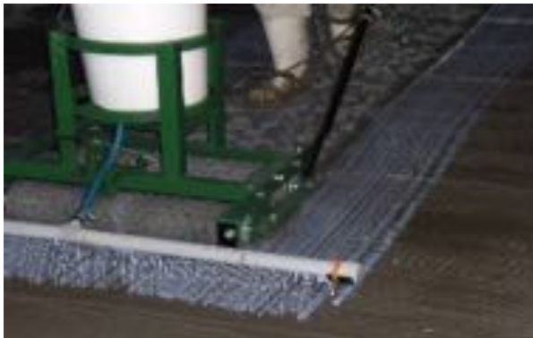
写真12 J P S工法専用改質材散布
