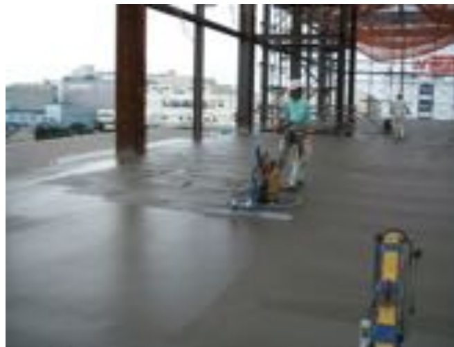
写真14 ハンドマンによる表面仕上げ
