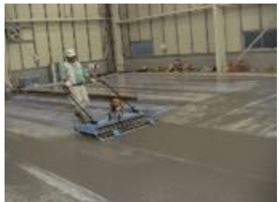
写真13 ローリーによる転圧、締固め
