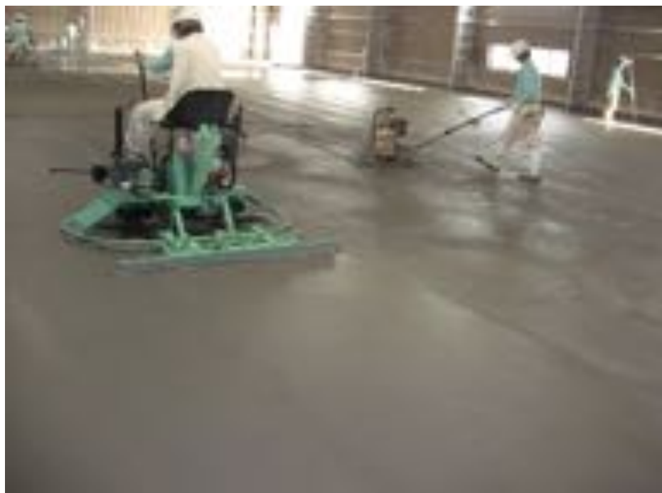
写真15 騎乗式ハンドマンによる表面仕上げ
