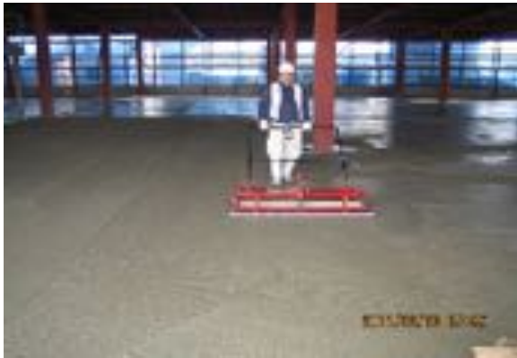
写真10 粗化機によるクシ引き
