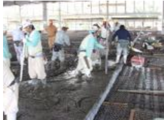
写真6 コンクリート打設
