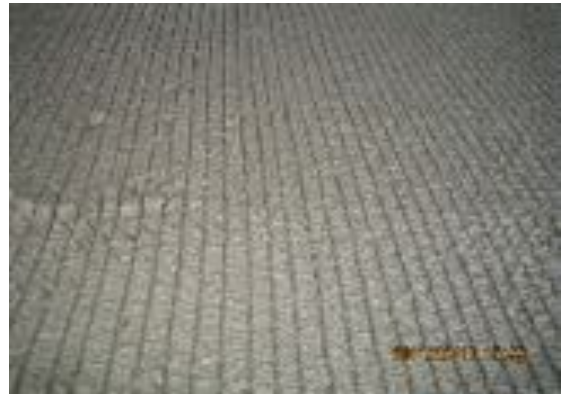
写真11 表面のクシ引き状況
