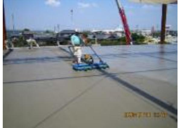
写真13 ローリーによる転圧、締固め
